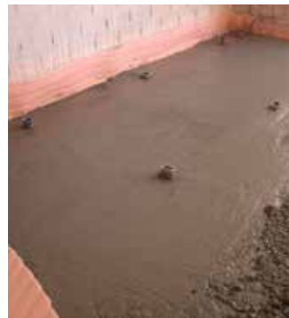
Colocacion del mallazo y hormigonado.
