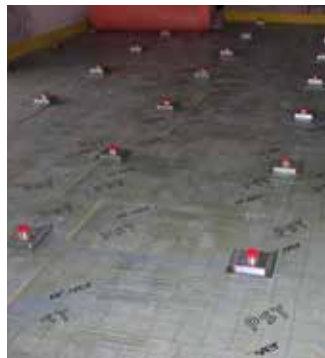
Acondicionamiento del local e instalacion de los soportes.
